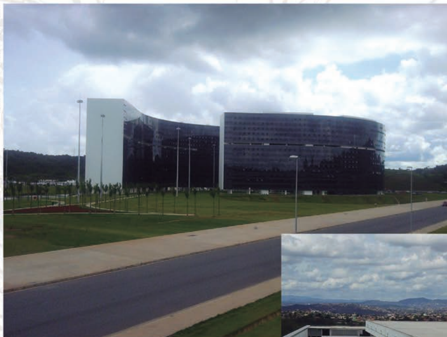
Cidade Administrativa - Belo Horizonte
